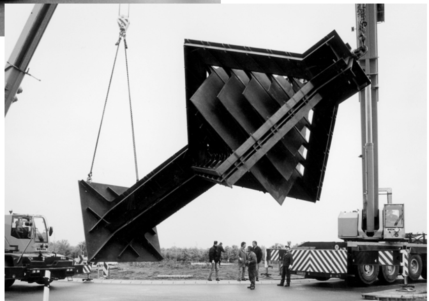
Aufrichten mit Schwerlastkran
